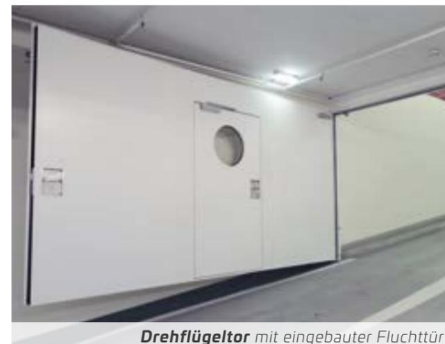
Drehflügeltor mit eingebauter Fluchttür
