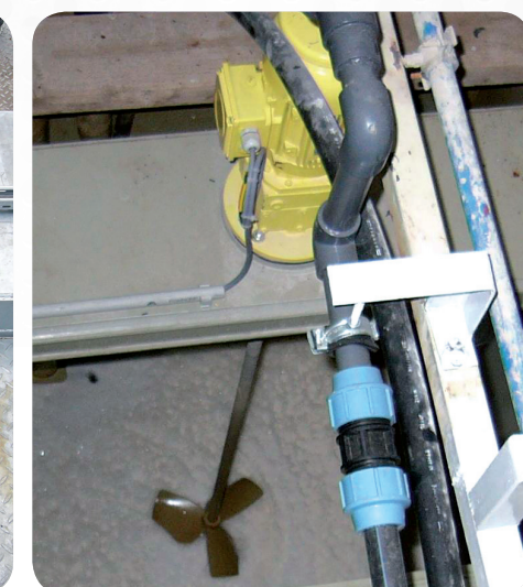
Mosószergyár szennyvízkezelés- keverő
