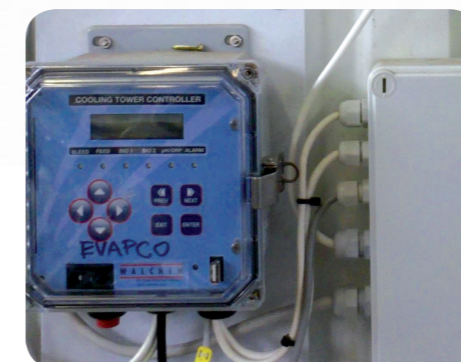
Ásványvíz üzem hűtőtorony-WCT műszer
