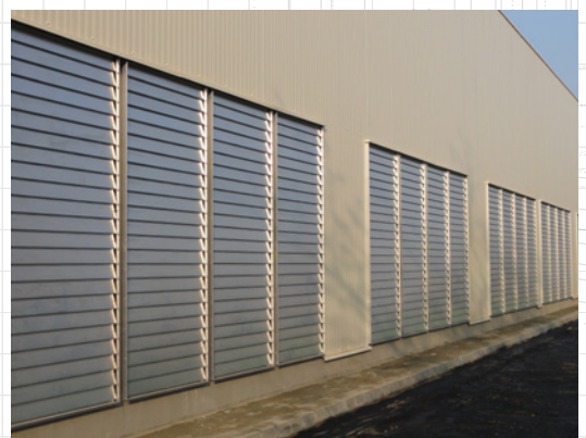
Az új csarnokrész már eredendően az új, korszerű rendszerrel került megépítésre: adiabaticus hűtés, légkezelők, természetes szellőztetés zsalus szellőzővel, hő- és füstelvezetéssel kombinálva
