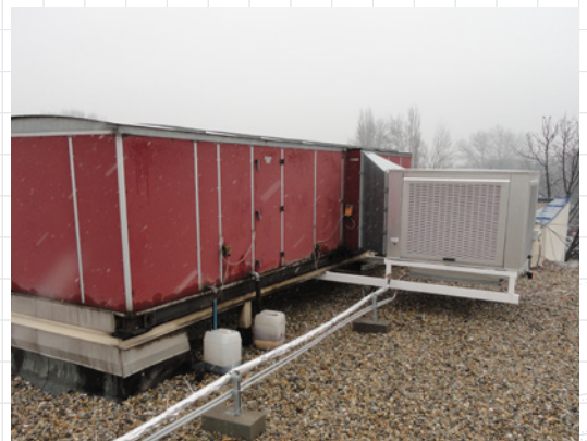
A meglévő csarnok légkezelője kapott egy adiabaticus hűtőberendezést
