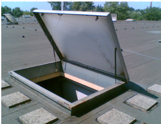
A meglévő csarnok bowdenes füstelvezetőjét (amely napi szellőztetésre nem is alkalmas) lecseréltük egy nagy hatékonyságú zsalus szellőzőre, esőbiztos alépitménnyel kombinálva.
