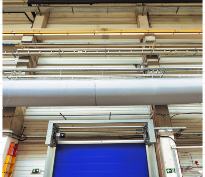
Adiabatikus hűtés, a beltérben szövet légcsatornával - Magyar Suzuki Esztergom
