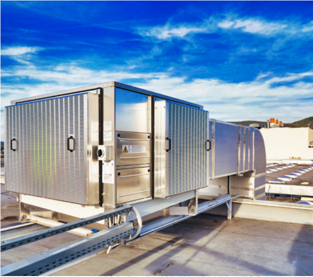
Adiabatikus hűtés, a beltérben szövet légcsatornával - Magyar Suzuki Esztergom
