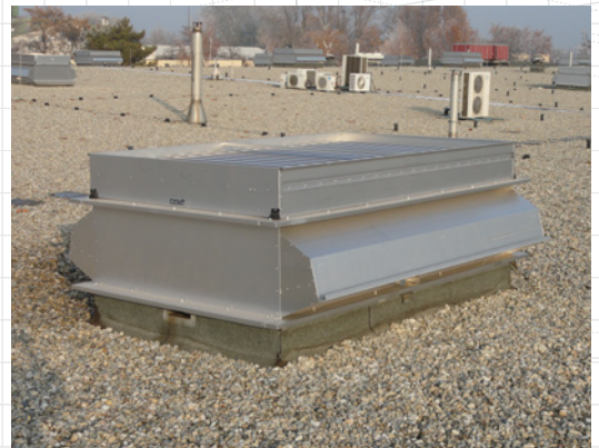
A meglévő csarnok bowdenes füstelvezetőjét (amely napi szellőztetésre nem is alkalmas) lecseréltük egy nagy hatékonyságú zsalus szellőzőre, esőbiztos alépitménnyel kombinálva.
