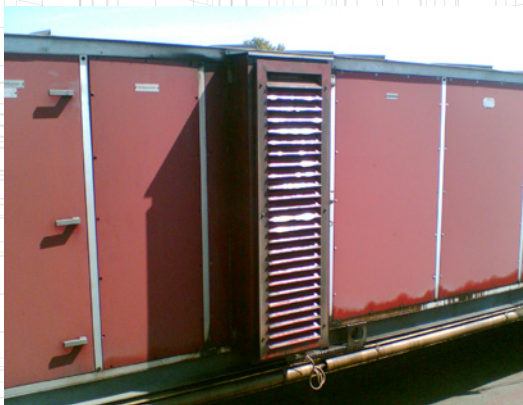
A meglévő csarnok légkezelője kapott egy adiabaticus hűtőberendezést
