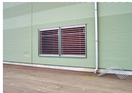
Új lamellás szellőzők, nagy megnyitott keresztmetszetek
